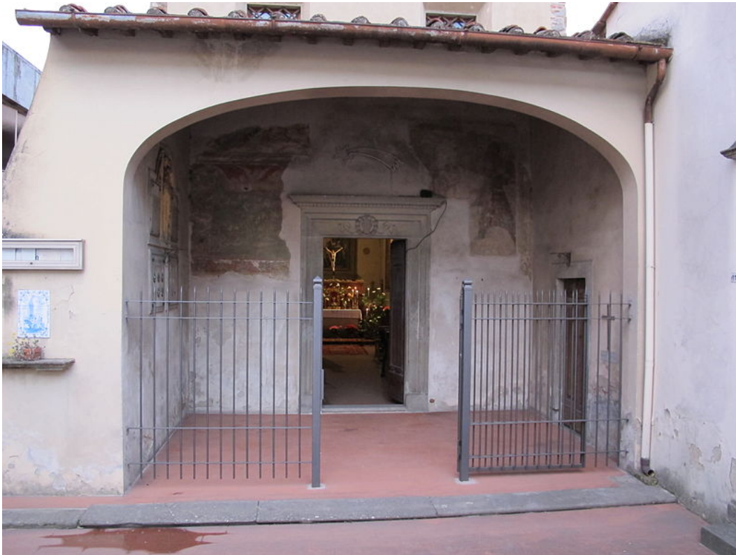
San Cristofano a Novoli; Entrance "little portico".
